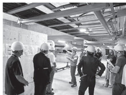
【免震装置見学】
