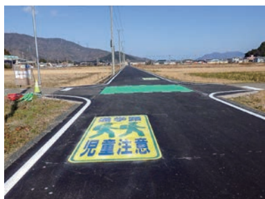
本郷岡田線の舗装
