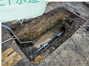
漏水修繕の様子
