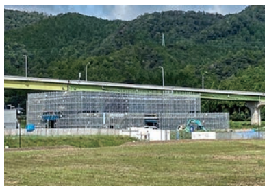
(株)TVE建設の様子
