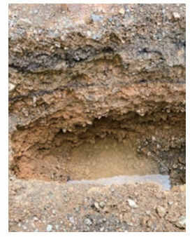
掘削時の水の状況
