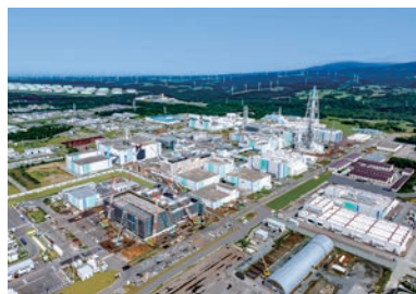
六ヶ所再処理工場
