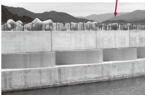
津波による影響を極力軽減するため、防波堤の高さを海拔 5 m から海拔 8 m にかさ上げしました。
