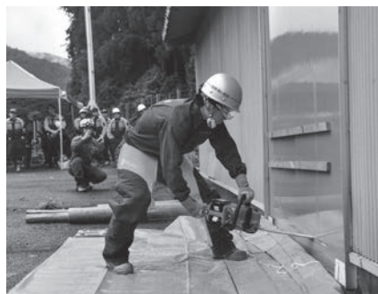
倒壊家屋救出訓練
