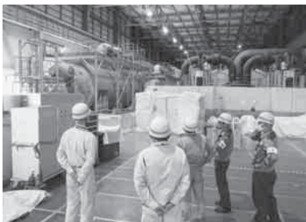
【現場視察の様子】
