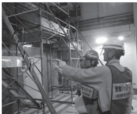
▲ 危険箇所の有無の確認(足場設置状況)
