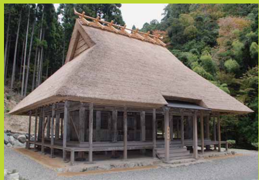
県指定文化財 薬師堂保存修理完了 落慶法要 (10月31日 名田庄納田終)
