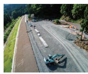
小浜綾部線盛土工事
