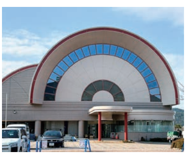
工事が進むフィットネスセンター
