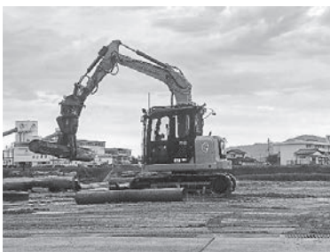
遠隔操作により動く重機
