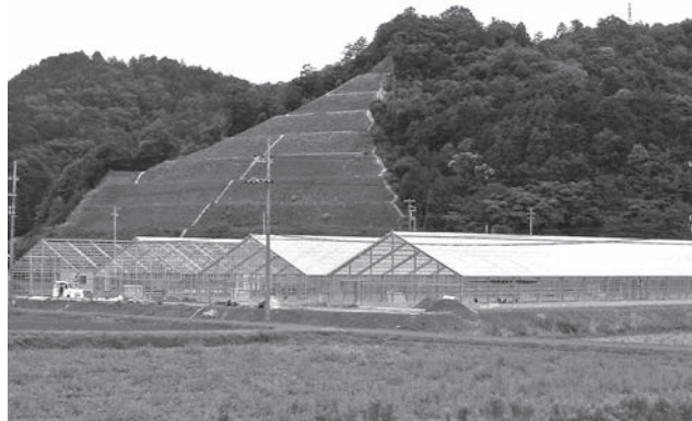
建設中の「イチゴ」ハウス
