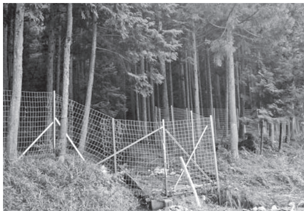
整備が進む山際恒久柵
