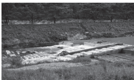
被災した頭首工
